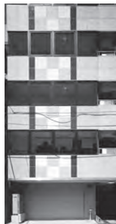
新橋ビル RC造 地下1F・地上8F
