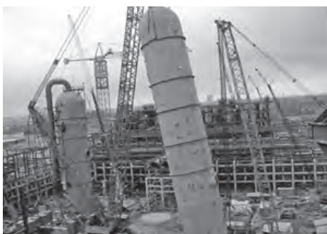
②建設現場
