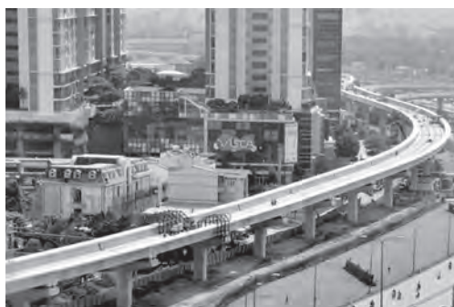
日本の協力で建設中の都市鉄道1号線（ホーチミン市）
